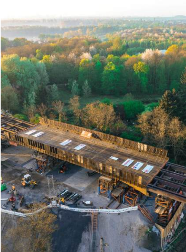
Die Cölvebrücke auf dem Vormontageplatz inklusive Vorbau- und Nachlaufschnabel.
