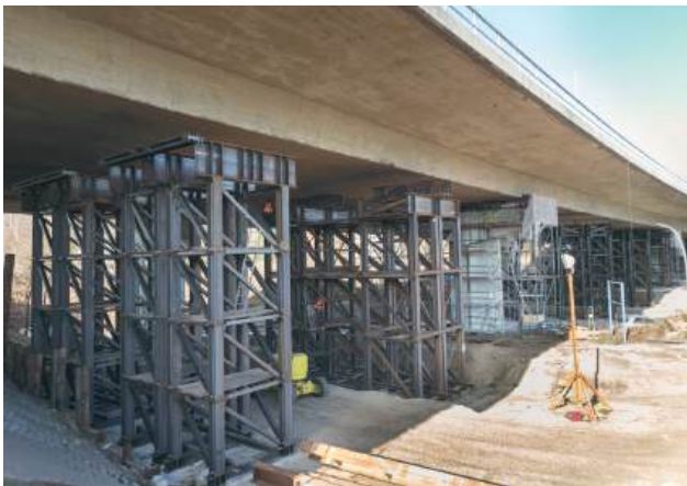
Langenfelder Brücke der A7, Hamburg: Für den hydraulischen Anhub und Verschub des Überbaus haben wir Stahlbaustützen, Traggerüste und spezielle Verschublager eingesetzt.
