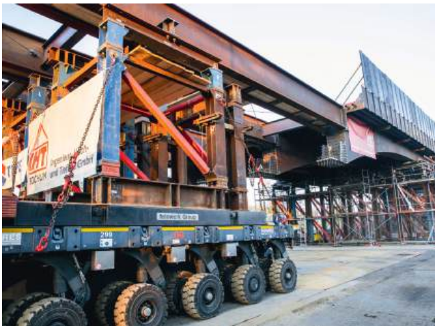
Die vier Bati-Türme der letzten Vershubachse auf SPMTs.
