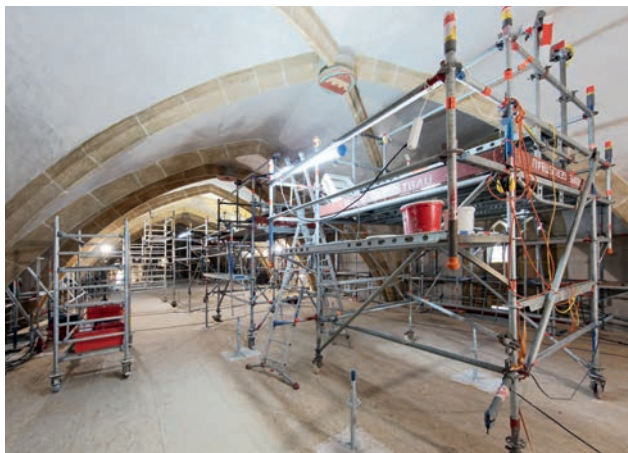
Innengerüst zur Sanierung des Kircheninnenraums
