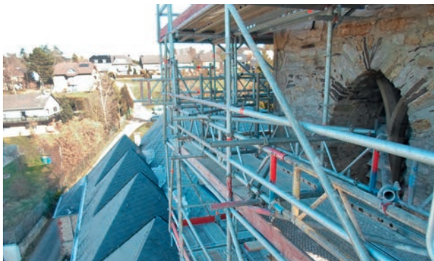
Überbrückung Kirche, Kirspenich (bei Bad Münstereifel)
