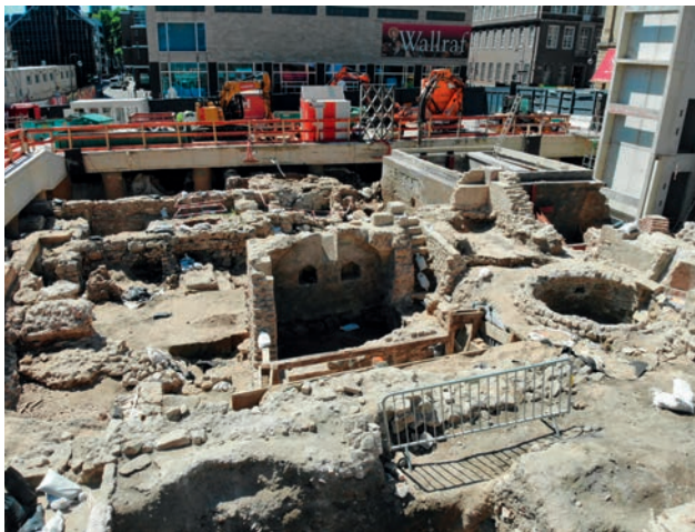
Örtlichkeit vor Baubeginn Arbeitsplateau
