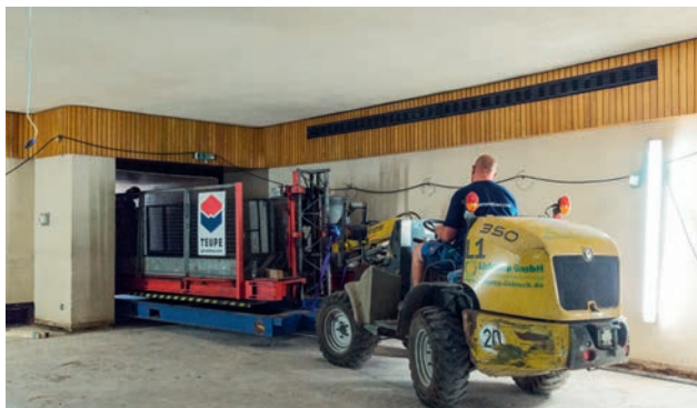
Aufzugstransport Beethovenhalle, Bonn
