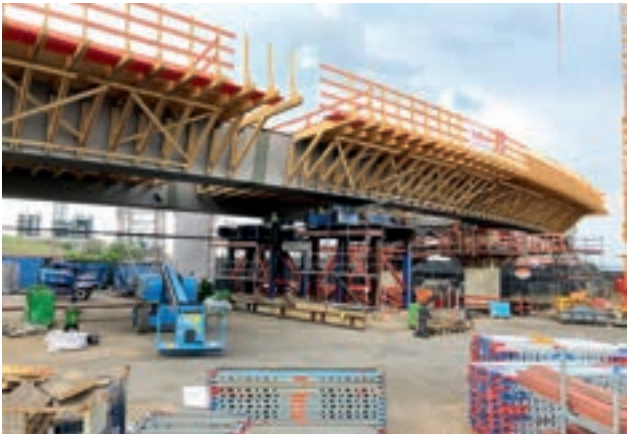
Verschub Stahltröge auf den Bati-Stütztürmen
