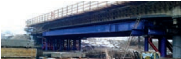
Stahlkonstruktion zur Abstützung des Brückenüberbaus
