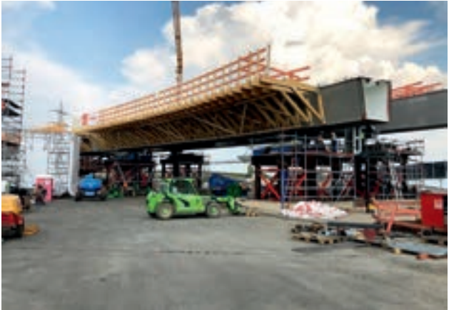
Verschweißen der Stahltröge auf den Bati-Stütztürmen
