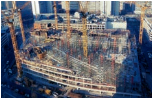
Neubau Axel Springer-Medienzentrum, Berlin
