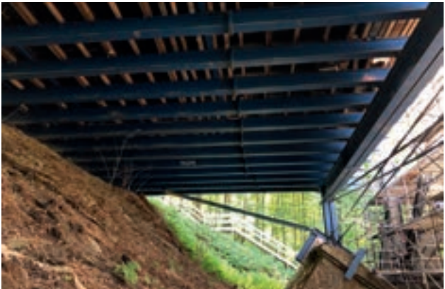
Objektbezogen angepasste Traggerüstkonstruktion
