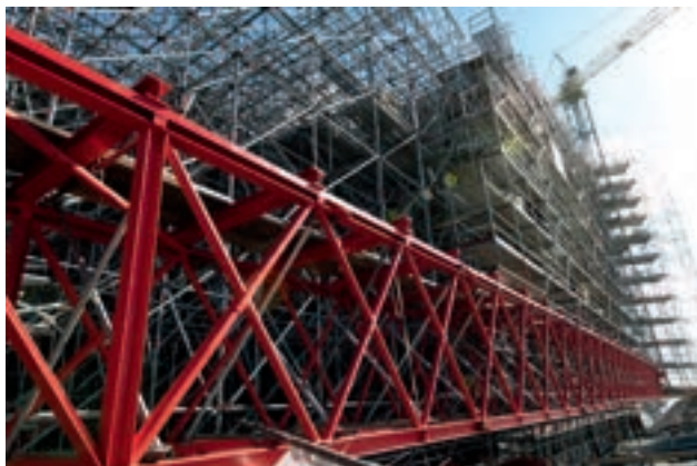
Überbrückung Audimax Leuphana Universität Lüneburg
