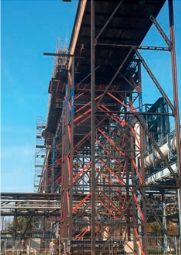
Traggerüst als Notunterstützung der Bandbrücke
