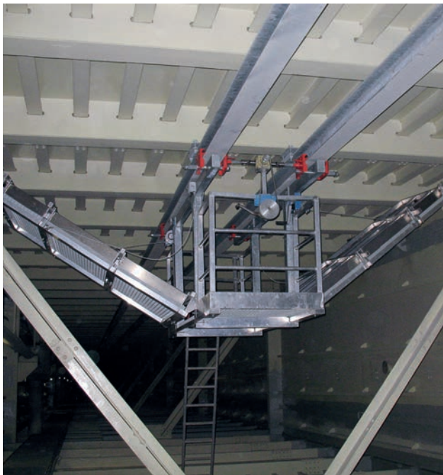
Brückenbefahranlage Düsseldorf-Neuss Südbrücke/Kardinal Frings Brücke
