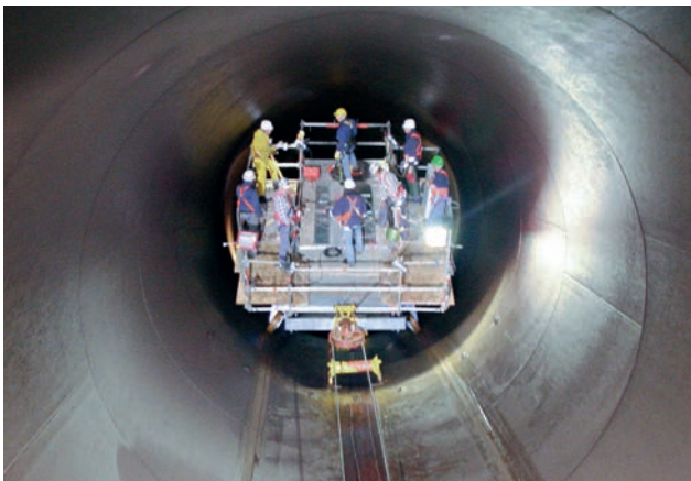
Druckrohrbefahranlage Waldeck II
