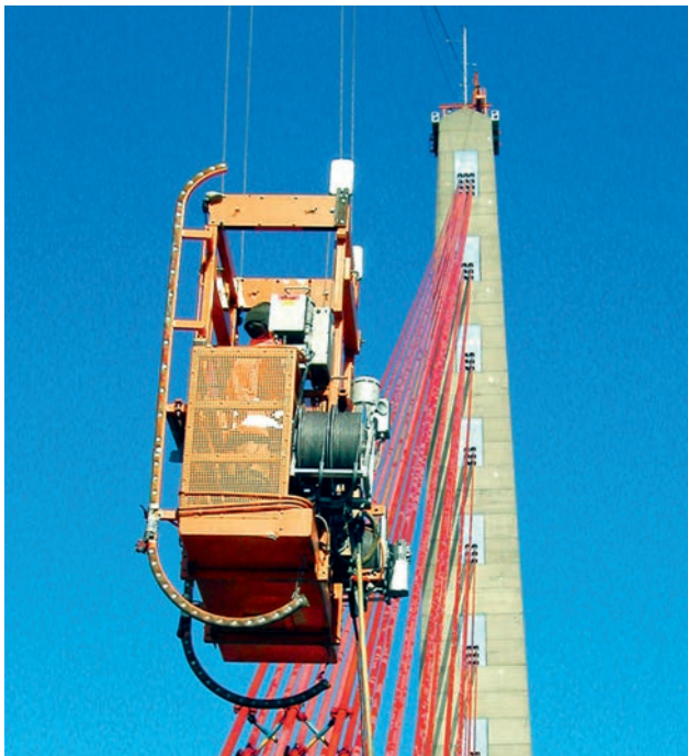
Brückenseilbesichtigungsgerät
