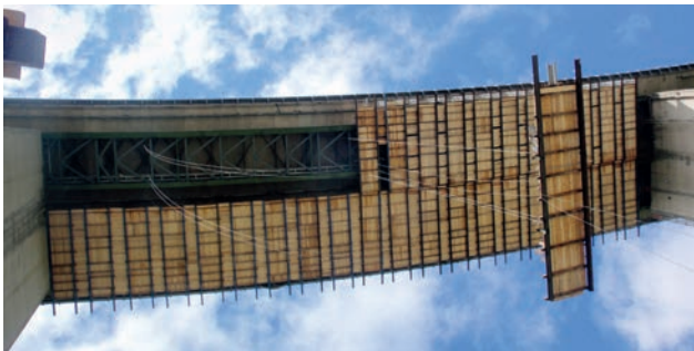
Rheinbrücke Leverkusen, Tandemkettenzug für Materialtransport über 300 m Fahrstrecke. Steuerung für Funkfernbedienung
