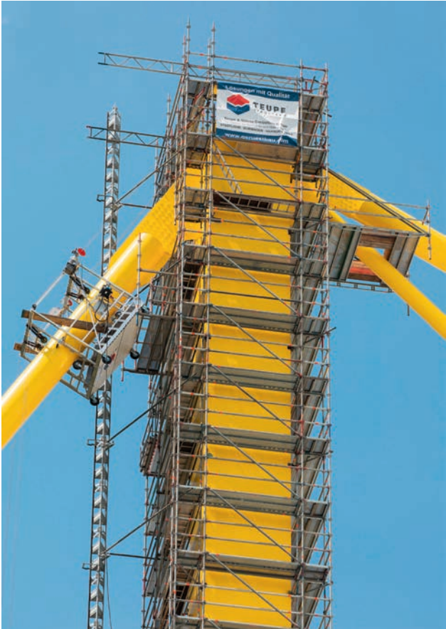
Befahranlagen an Schrägrohren Stahlbau, Signal Iduna Park Dortmund
