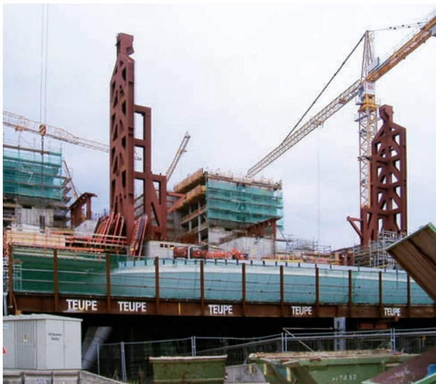
Airrail-Center Frankfurt, Traggerüst
