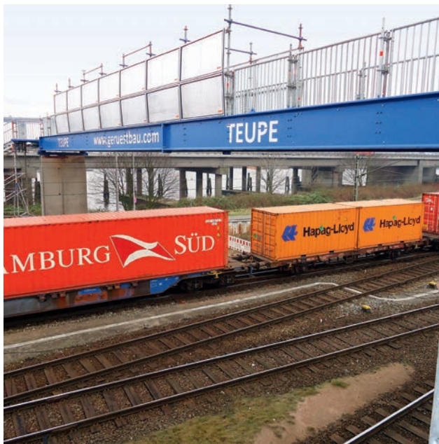
Burchardkai Hamburg: Behelfsbrücke für Fußgänger- und Radfahrer
