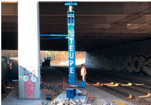
Temporäre Hilfsunterstützung, Stahlbau- und Hydraulikleistungen
