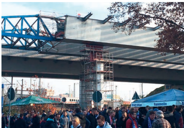
Gerüstbauleistungen für den Stahlbau
