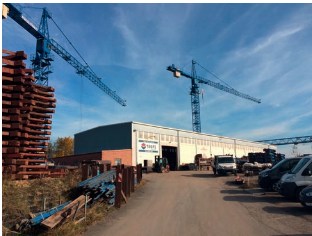
Teilansicht Standort Jena
