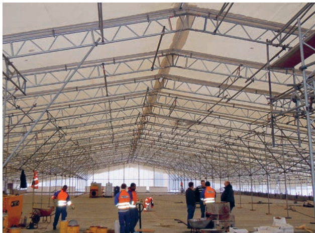
Kederplanendach als temporäre Schutzeinhausung, Gütersloh
