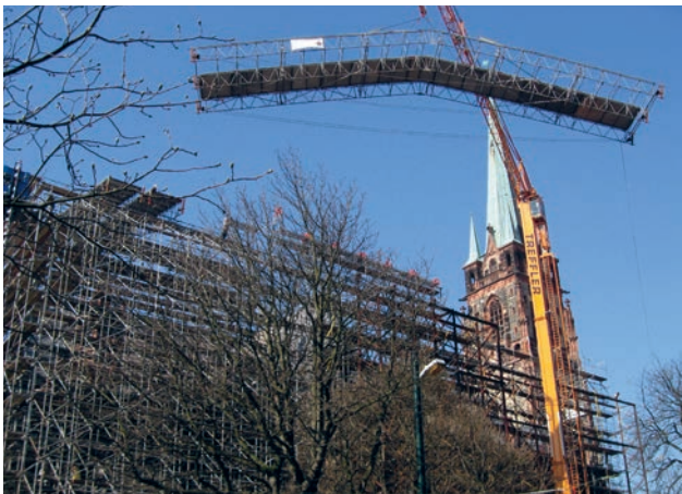
Freistehendes Wetterschutzdach Kirche St. Peter, Düsseldorf
