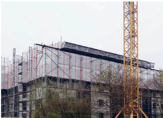
Elektrisch verfahrbares Kassettendach, Braunschweig
