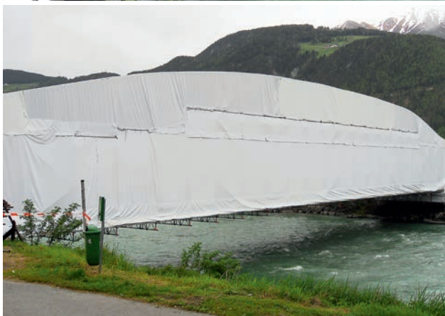
Brückeneinrüstung für schwere Korrosionsschutzarbeiten mit ZTV-Ing-Einhausung
