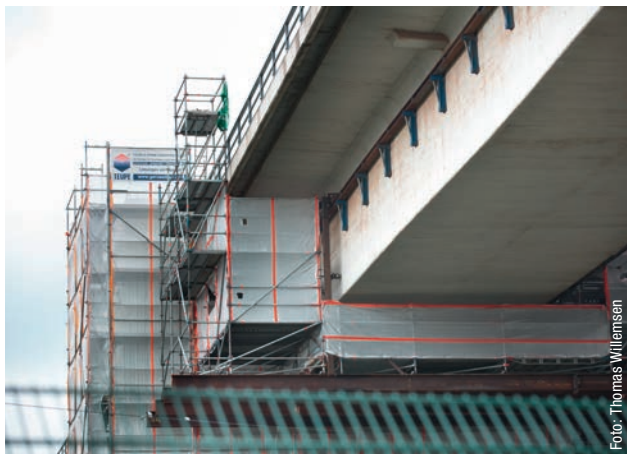
BAB A 59 Brückenzug „Berliner Brücke“ bei Duisburg
